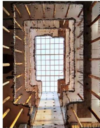
Zu Beginn wurden das Kakaobohnen-Silo und das Treppenhaus abgebrochen.
